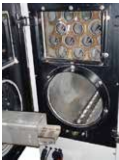
Extracción de cenizas automática
