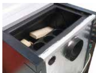
Acceso al intercambiador de calor
